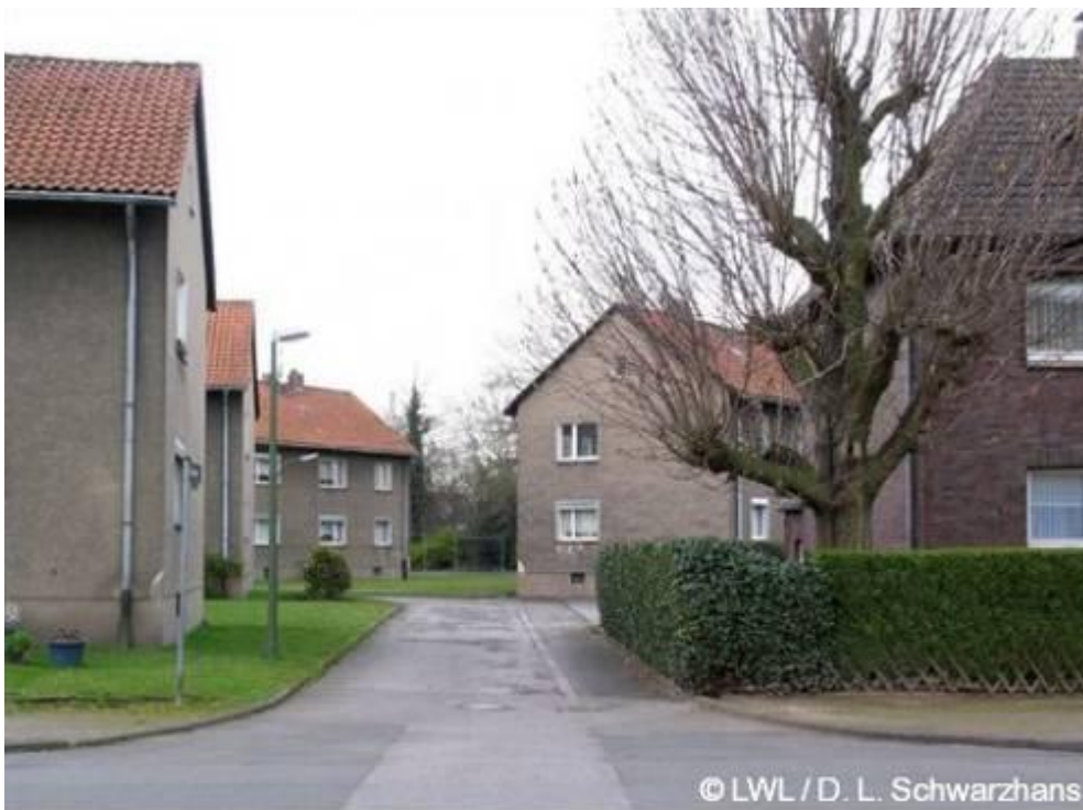
Siedlung Sonnenschein – An der Straße Dünnebank ist gegenüber der Henrichenburger Straße ein Wohnhof abgesetzt, um den sich die zweigeschossigen Mehrfamilienhäuser gruppieren.
