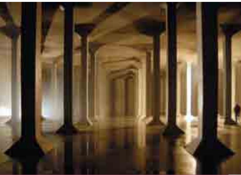
„Kathedralen der Unterwelt“, Baujahr 1939, Wasserbehälter der DEW21 in Dortmund- Berghofen Hüllberg | Foto: B. Holthaus/DEW21
