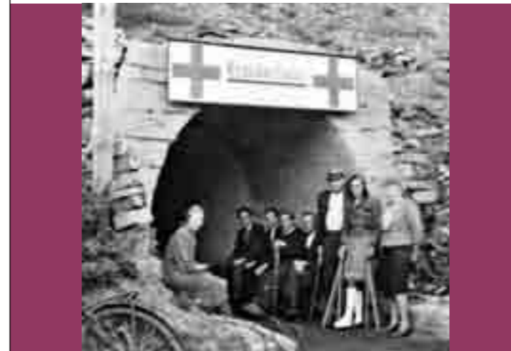
Das Stollenkrankenhaus in Gladbeck, 1945/46 Foto: Stadtarchiv Gladbeck
