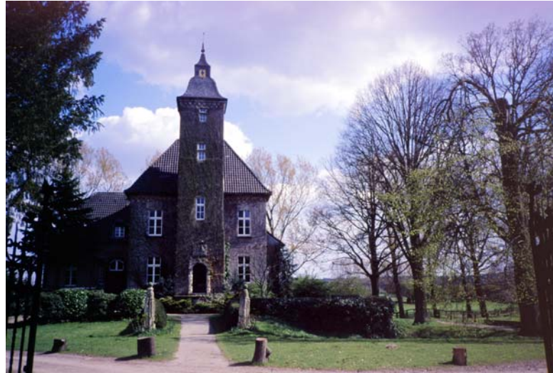
△ Hünxe-Drevenack, Wasserburg Haus Schwarzenstein Foto: LVR/W. Wegener
