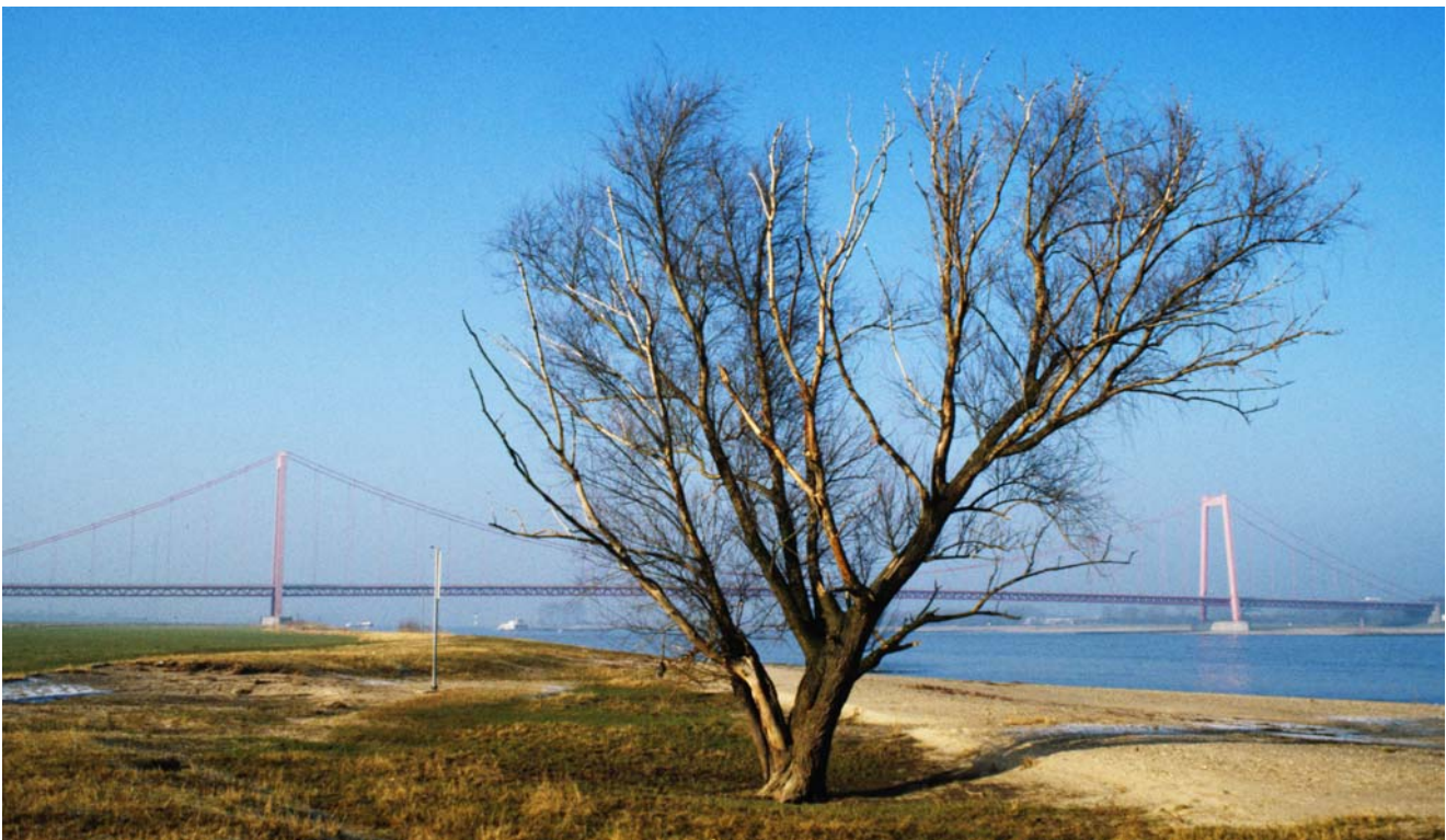
Wesel, Rheinbrücke △ Foto: LVR/J. Gregori
