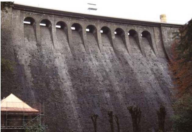
▽ Sperrmauer der Aggertalsperre bei Engelskirchen Foto: LVR/W. Wegener
