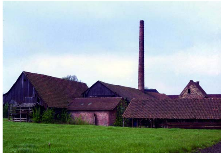
Rheda-Wiedenbrück, Ziegelei Foto: LWL/E. Lubahn
