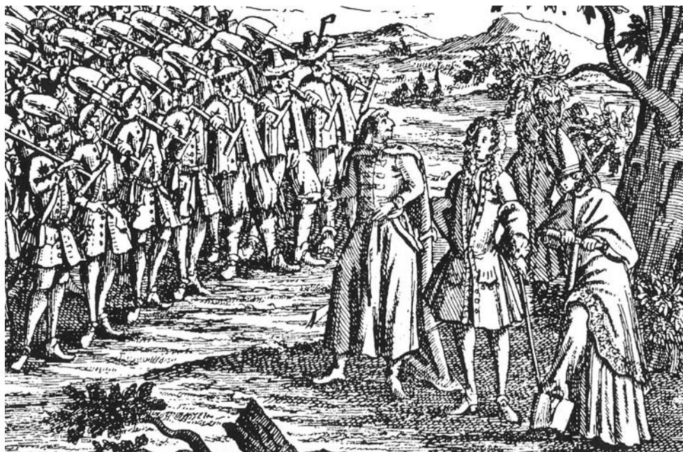
Abbildung 2.36: Spatenstich zum Bau des (späteren) Max-Clemens-Kanals durch Kurfürst Clemens August am 09.05.1724.
